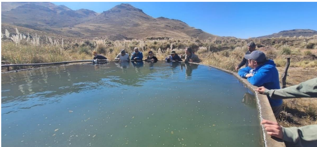
Fotografía 45: Tanque de almacenamiento de agua depurada para su reutilización. Foto: D. Ulla.
