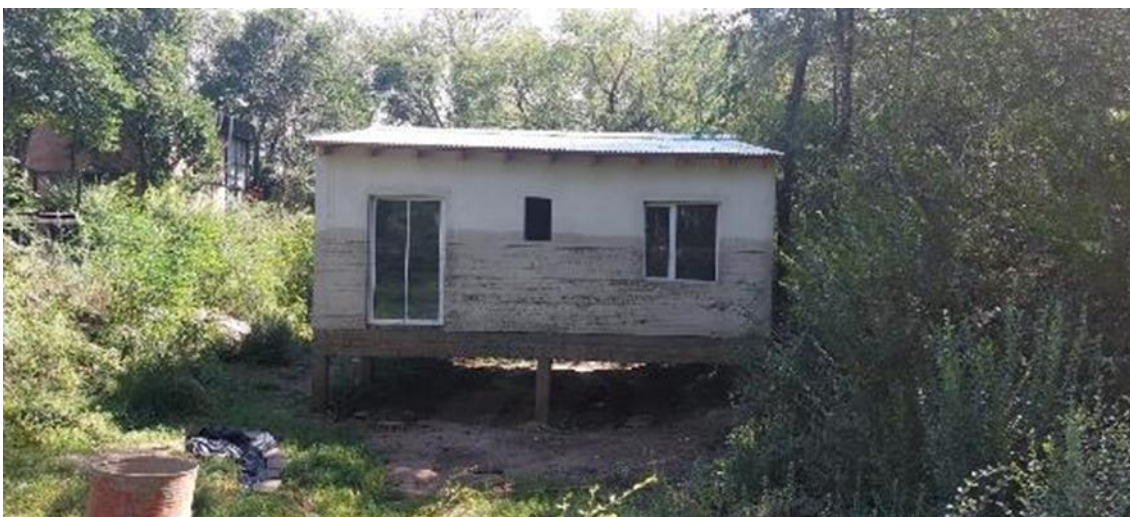
Fotografía 77: Vivienda en construcción a la vera del río. Se aprecia el nivel al que llegó en agua por sus marcas en los muros. Foto: Daniel Ulla.
