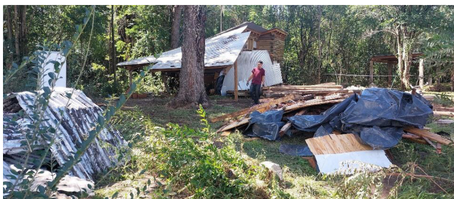
Figura 34. Daños materiales ocasionados por la crecida y desborde del río Quillinzo.
