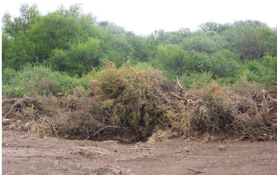
Figura 23. Desmonte con topadoras.
